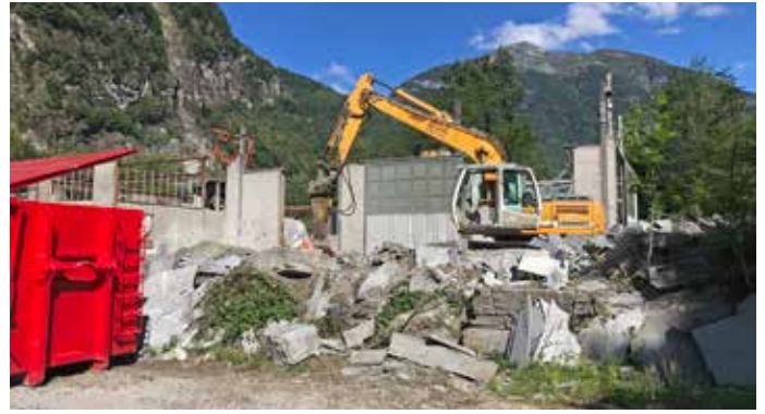
Demolizione di edifici in zona golenale nel giugno 2020.
