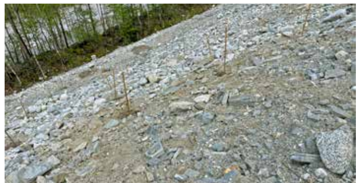
Piantumazione e rinverdimento di scarpate nel maggio 2024.
