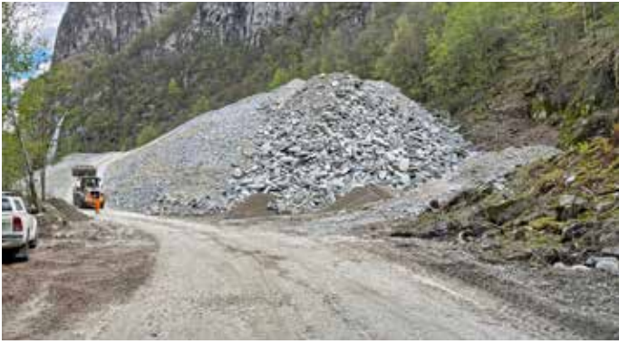
Deponia definitiva di scarti di cava in sponda destra nell'aprile 2024.
