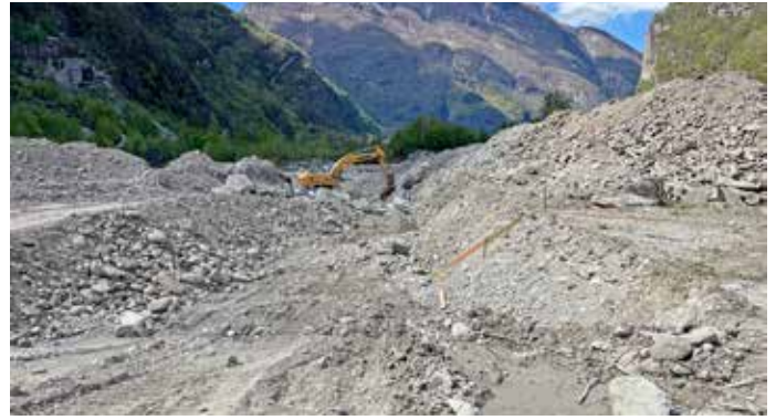
Costruzione di argine nell'aprile 2024.
